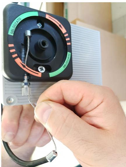
Вставьте стальной трос внутри ручки разблокировки и оболочки так, чтобы он прошел до электрозамка.
