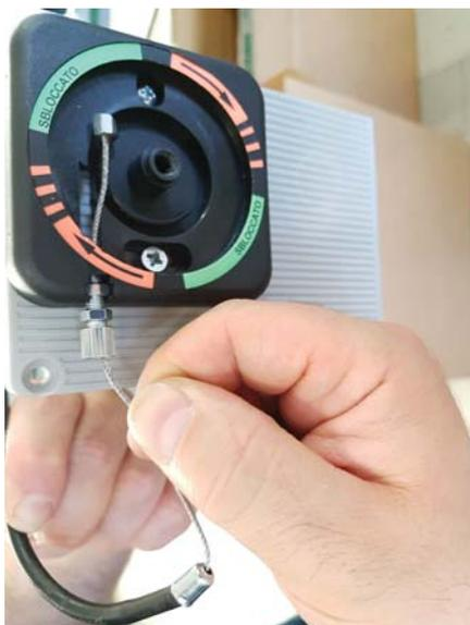
Вставьте стальной трос внутрь ручки разблокировки и оболочки так, чтобы он прошел до электрозамка.
