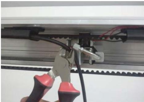
Вставьте изоляционную оболочку через кабельные вводы так, чтобы она прошла до электрозамка.
